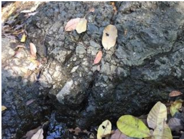
Fotografía 7. Detalle del plano de la fotografía anterior donde se observa que las fracturas con orientación aproximada NS se presentan saturadas y se observa descarga de agua, coordenadas 341760-231425, proyección Lambert Norte
