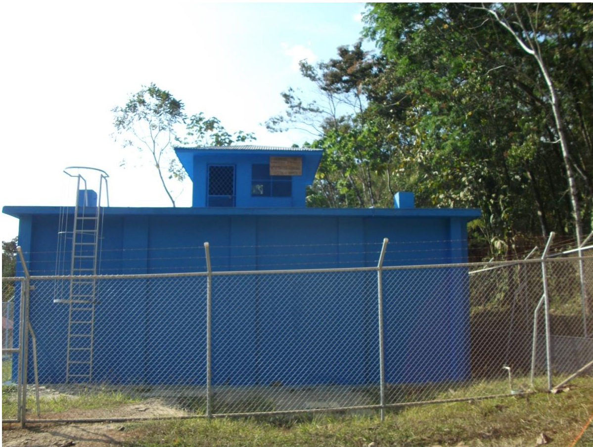
Figura 52: Tanque de almacenamiento de agua de la asada Uvita-Bahía.
