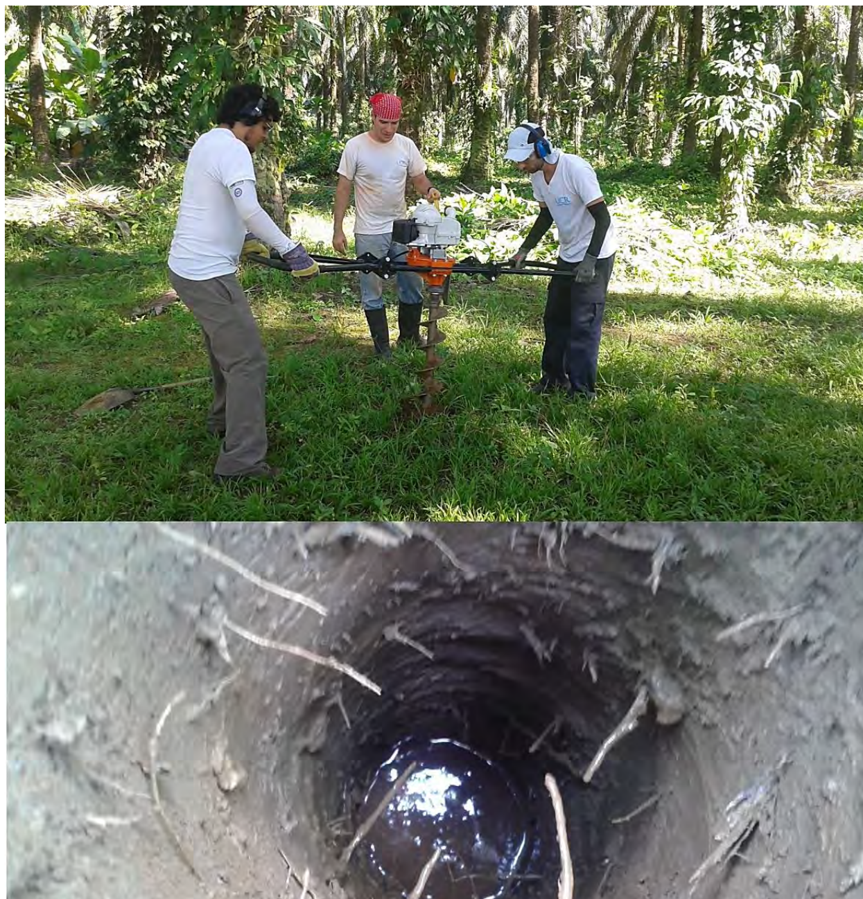
Figura 34: Ejecución de una perforación manual, nótese en la parte inferior la presencia de un nivel de agua a aproximadamente 1 m de profundidad. Fuente: Elaboración propia.
