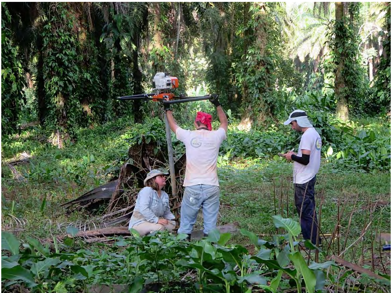
Figura 33: Hoyadora manual utilizada para la prospección del nivel de agua superficial. Fuente: Elaboración propia.
