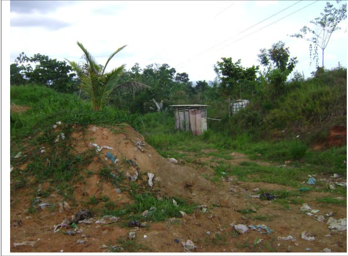
Figura 69: Problemática respecto a la escasez de material de cobertura sobre los desechos, causando su exposición en superficie. Fuente: Elaboración propia.
