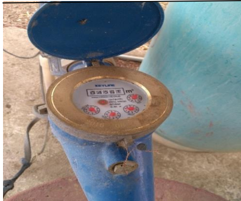
Caudalímetro observado en el Pozo CN-510
