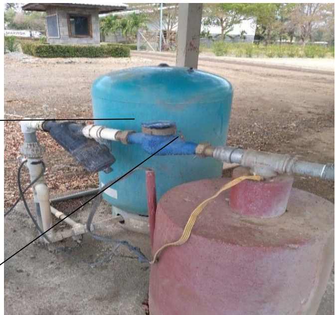
Caudalímetro observado en el Pozo CN-510
