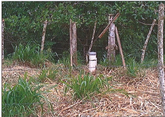
Figura 37: Fotografía del pozo 2 de la ASADA Chambacú.
