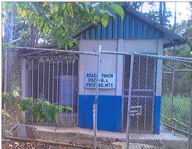
Figura 23: Fotografía del pozo 4 de la ASADA Pavón.
