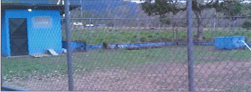
Figura 9: Fotografía de la propiedad donde se ubican los pozos Los Tanques 1 y 2.
