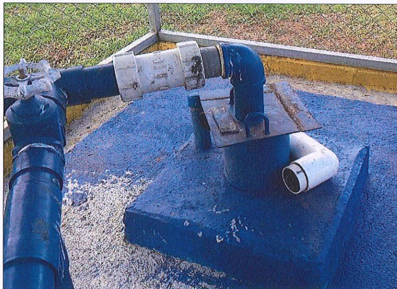
Figura 34: Fotografía del pozo CH-25.
