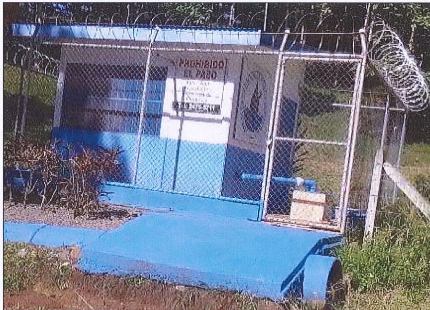
Figura 12: Fotografía del pozo de la ASADA Florencia.
