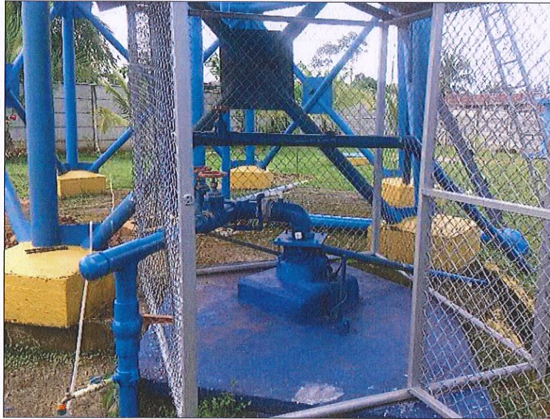
Figura 33: Fotografía del pozo CH-24.
