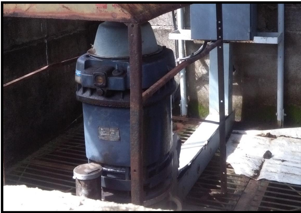
Figura 17. Décima sexta toma de agua encontrada en el sitio perteneciente al expediente 5558 a nombre de Hacienda Tempisque S.A. conocida como “Plazuela”
