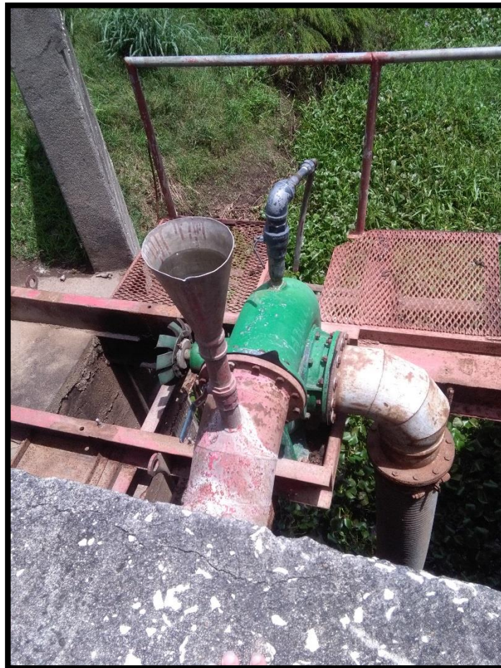
Figura 23. Vigésima segunda toma de agua encontrada en el sitio perteneciente al expediente 2316 a nombre de Central Azucarera Tempisque S.A. conocida como “Caimito”
