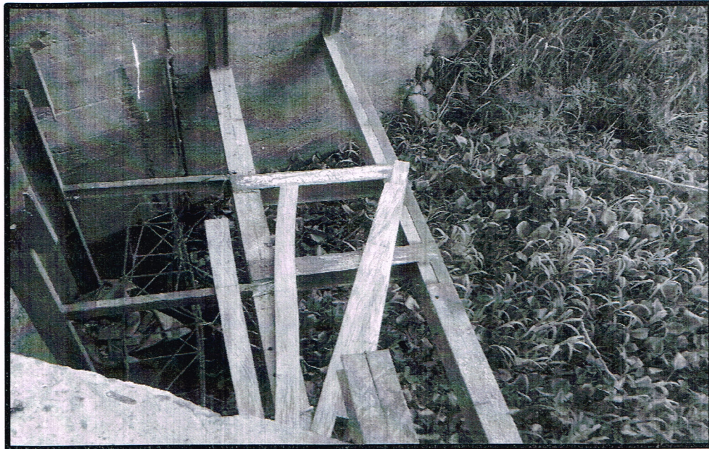
Figura 27. Vigésima primera toma de agua encontrada en el sitio perteneciente al expediente 6399 a nombre de El Rancho Gesling S.A. conocida como "Birmania"
