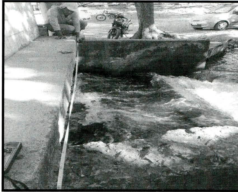
Figura 16. Primer aforo realizado a 10 metros de la tubería de descarga de la bomba del expediente 12395 sobre el canal en fecha 30/01/2017.
