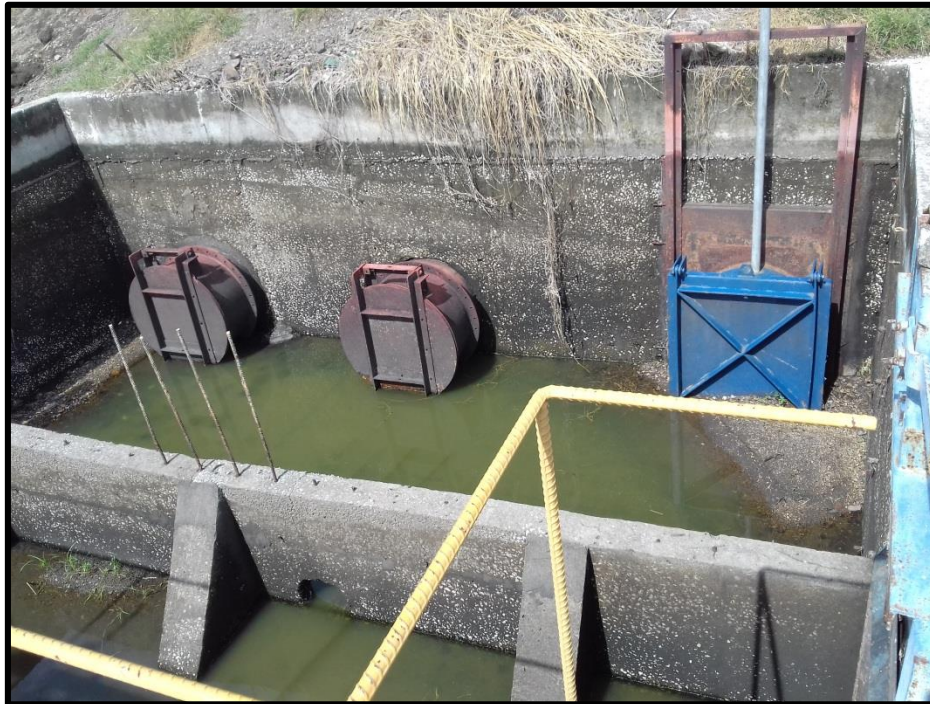
Figura 12. Décima segunda toma de agua encontrada en el sitio aprovechada por Azucarera el Viejo, está bajo concesión con el SENARA.
