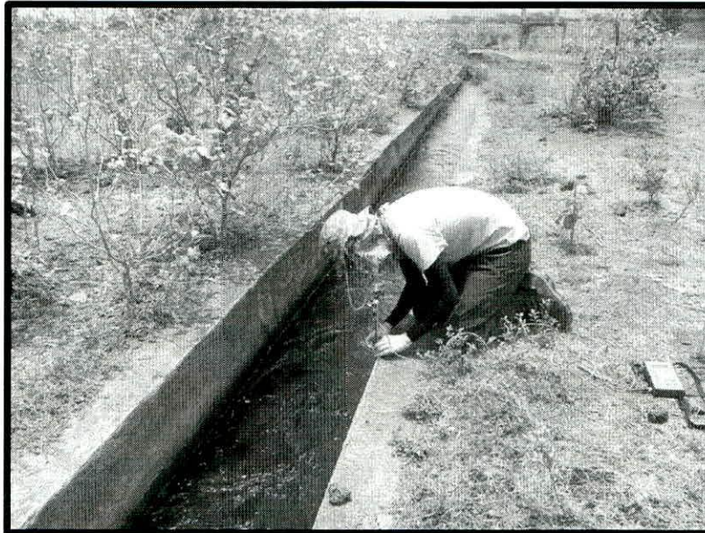
Figura 12. Tercer aforo realizado a 5 metros aproximadamente de la salida de agua de la tubería al canal de la toma de aprovechamiento de agua conocida como "La Plazuela" con fecha 27/04/2016.
