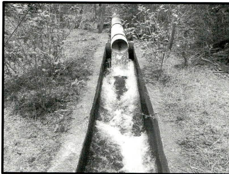
Figura 11. Canal de la toma de aprovechamiento de agua conocida como “La Plazuela” con fecha 27/04/16.
